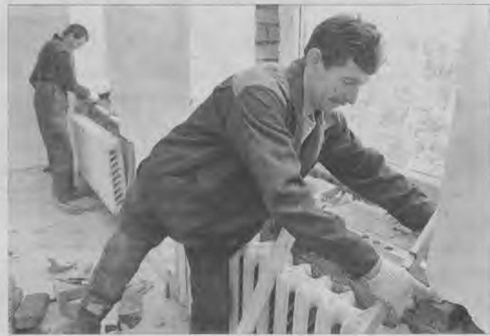
К 1 сентября здесь будут новые оконные рамы.
