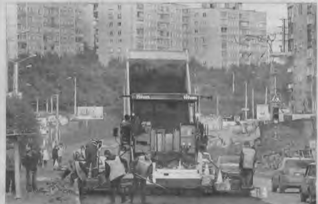
Ремонт Кольского проспекта начался в 2007 году.
