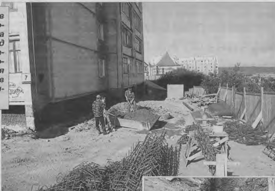
Двор, который сегодня похож на стройплощадку, будет благоустроен.
