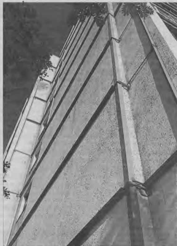
Здание "огели" в прочный каркас.
