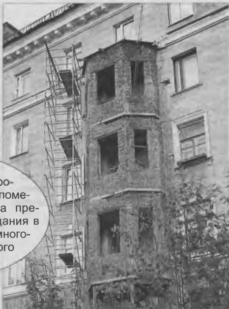
Скоро рабочие начнут устанавливать оконные рамы.
