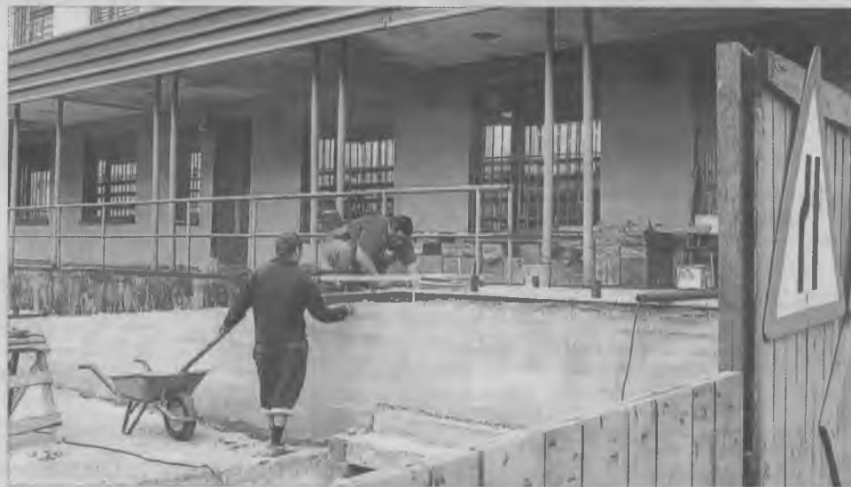
У входа в поликлинику оборудуют современный пандус.
