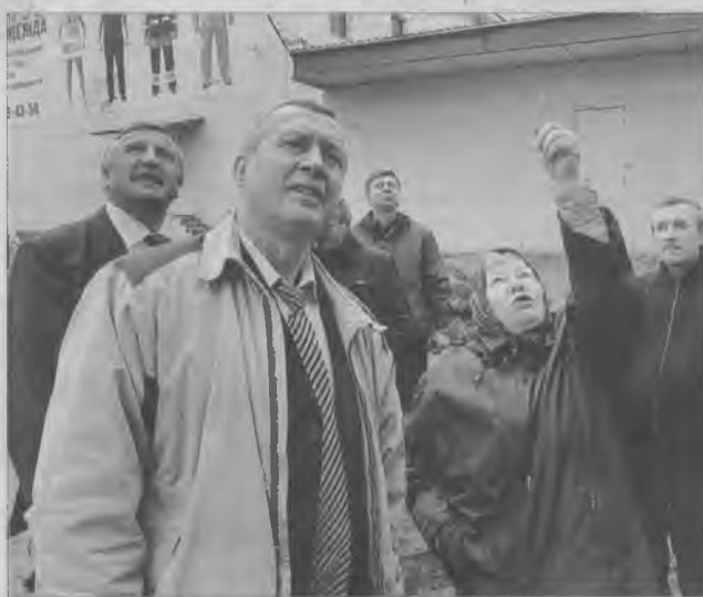
Жильцы дома № 4 на улице Успенского требуют ремонта кровли.
