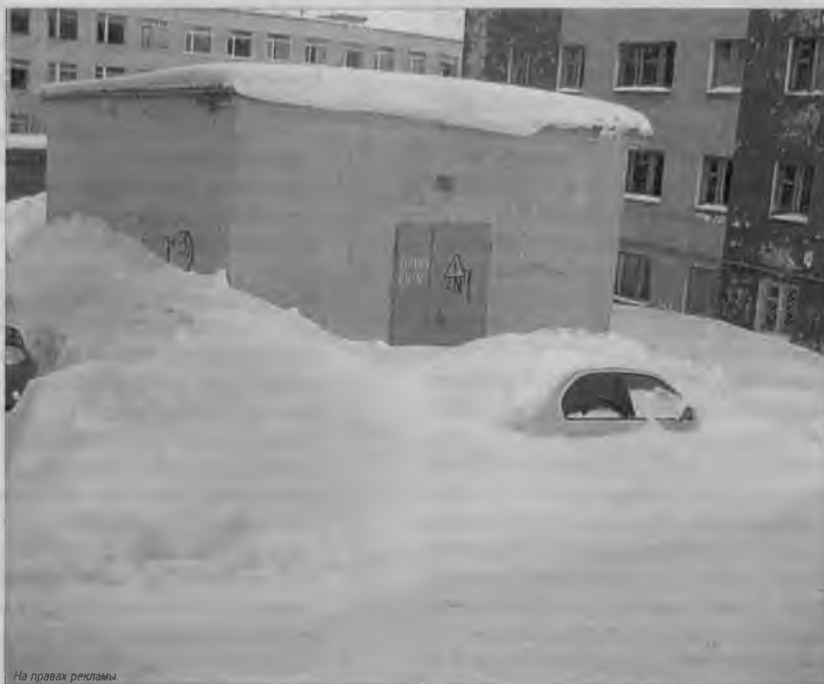
155-я подстанция на улице Полярные Зори. Трехметровый сугроб с "подснежником" блокирует энергетикам доступ к оборудованию.
