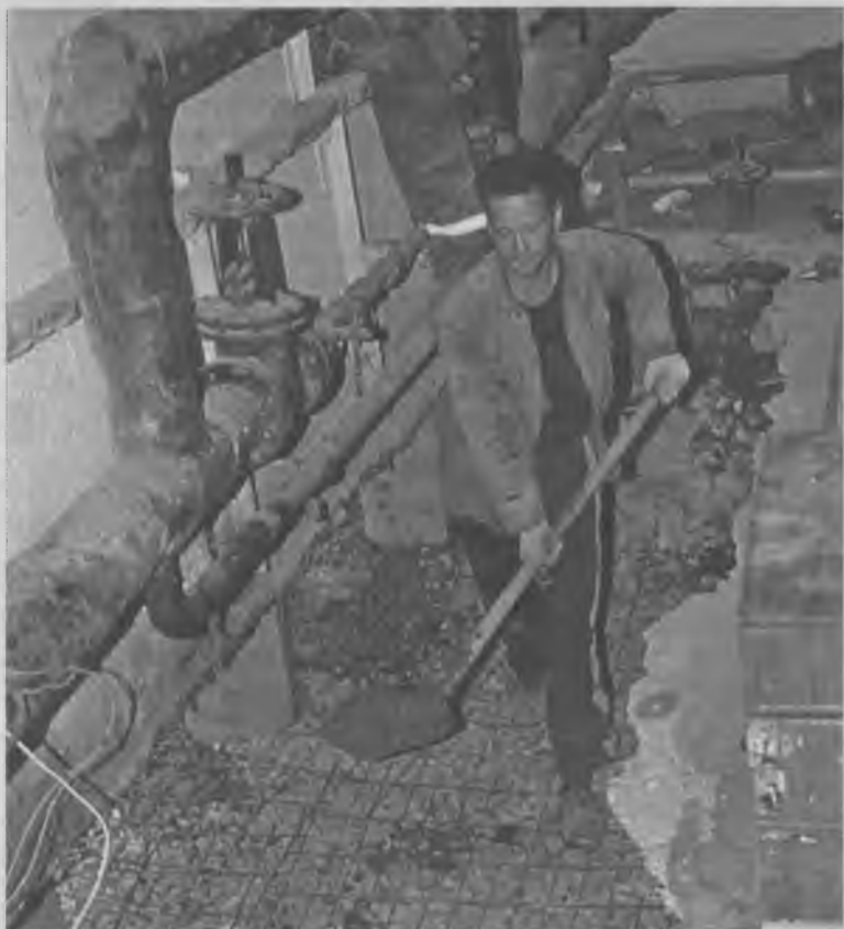
Ремонтные работы на инженерных сетях завершены на 13 участках.
