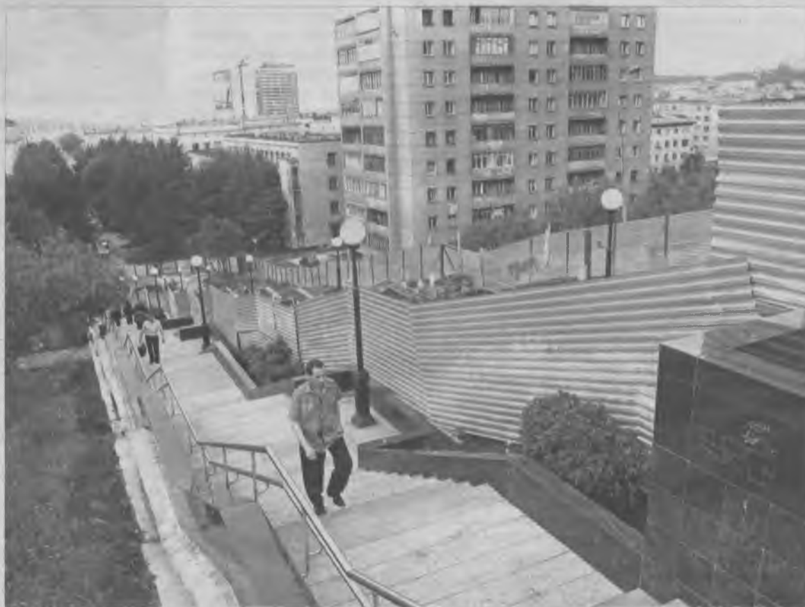
Все ремонтные работы на лестнице на улице Воровского будут завершены к концу августа.
