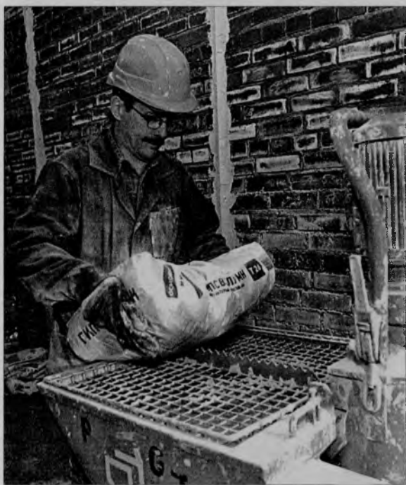
На третьем этаже социального дома уже идут отделочные работы.
