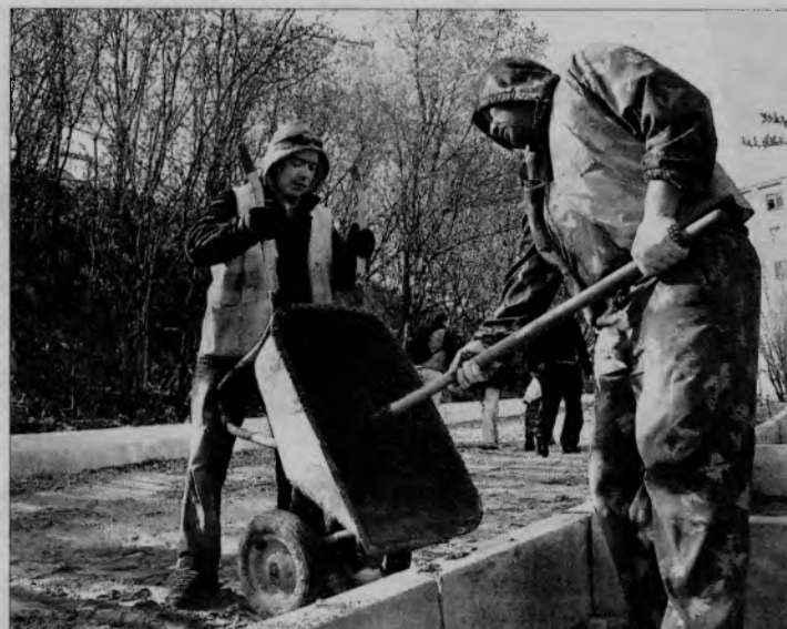
Дорогу на улице Куйбышева отремонтируют к середине июня.
