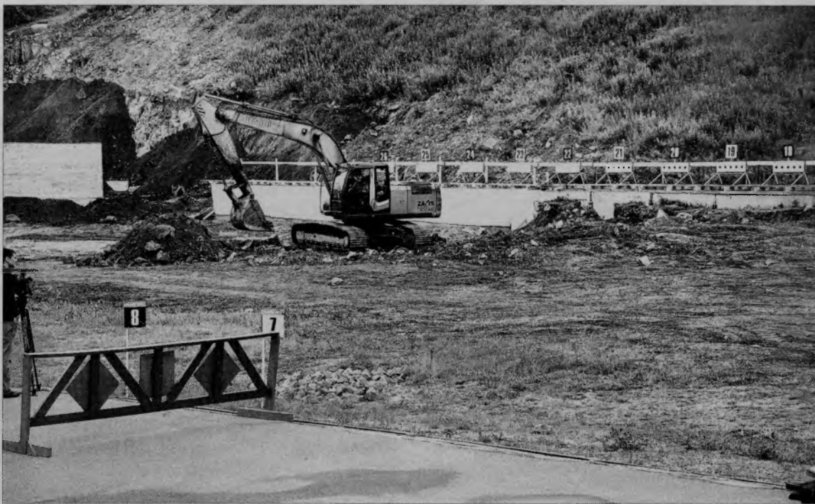
Строительные работы в Долине Уюта идут полным ходом.
