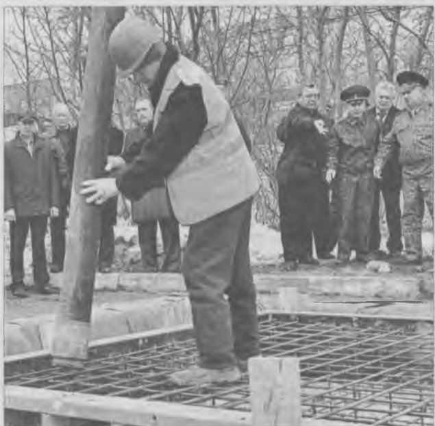
После того как монетки на счастье кинуты, можно заливать фундамент цементом.
