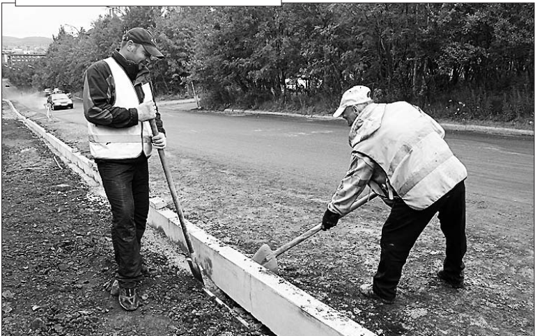
Рабочие занимаются установкой бортового камня.
