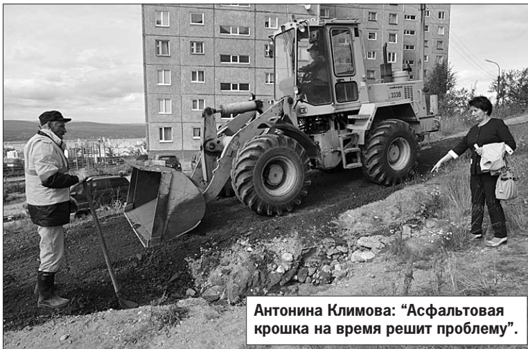
Последствия ливня устранены.
