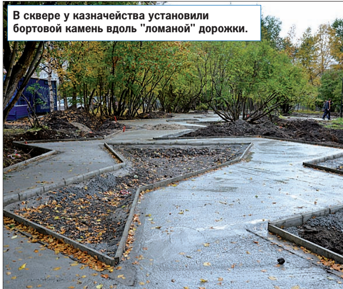
Завершена работа по укладке плитки в центре сквера на улице Зои Космодемьянской.
