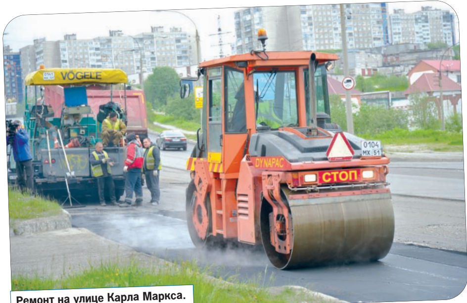
Ремонт на улице Карла Маркса.
