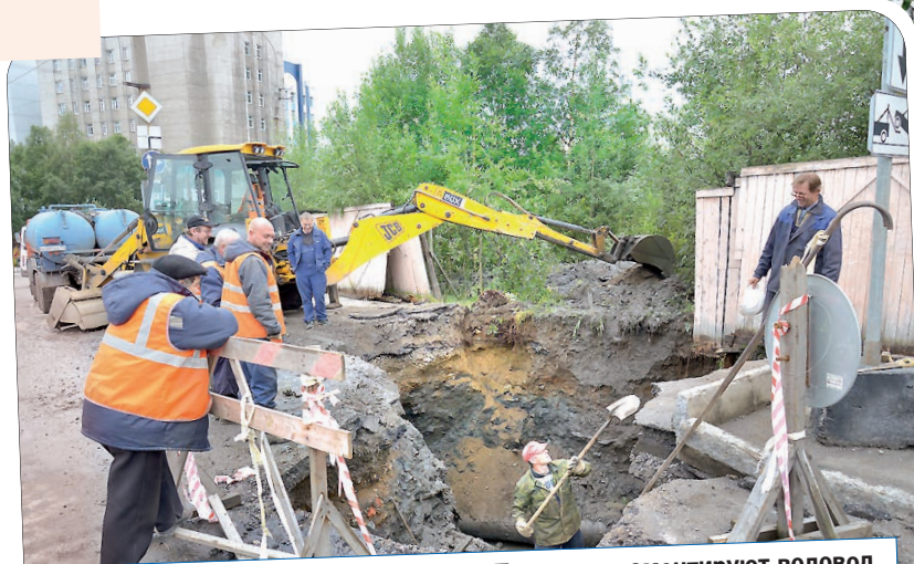
На перекрестке улиц Карла Маркса и Папанина ремонтируют водовод.
