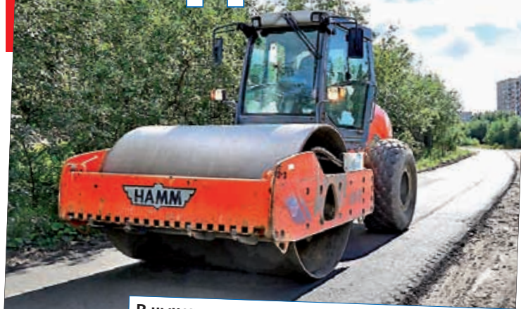
В нынешнем году на улице Саши Ковалева укладывают нижний слой асфальта — основание. Работы продолжатся в следующем году.
