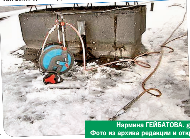
Так выглядит оборудование для установки заглушки.
