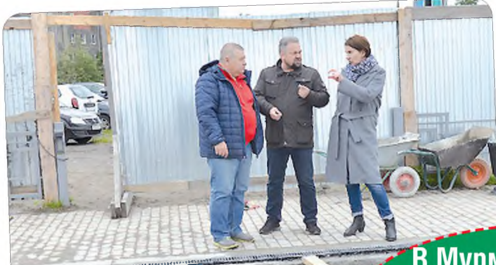
Александр Накай (в центре) и Ирина Мазилкина обсуждают с подрядчиком ход ремонтных работ на площадке у «Ждущей».
