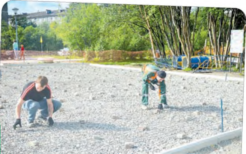
Рабочие готовятся к укладке современного тартанового покрытия.
