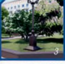
Опора освещения – 56 ед.
