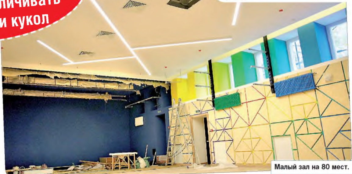
В холле завершается отделка.
