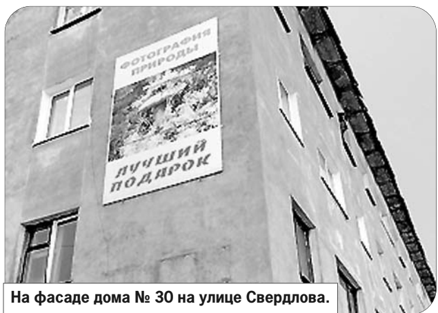
На фасаде дома № 30 на улице Свердлова.
