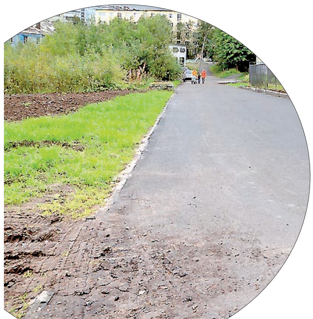
Дорогу на улице Кирпичной временно оградят блоками.
