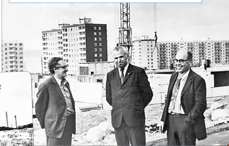
Гридор Климов (справа) на одном из строительных объектов Мурманска.
