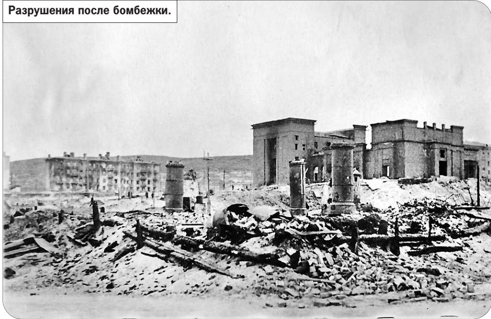
Разрушения после бомбежки.
