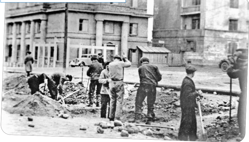
Ремонтные работы на проспекте Сталина.
