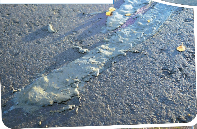
Так производили ремонт нового асфальта в конце сентября.
