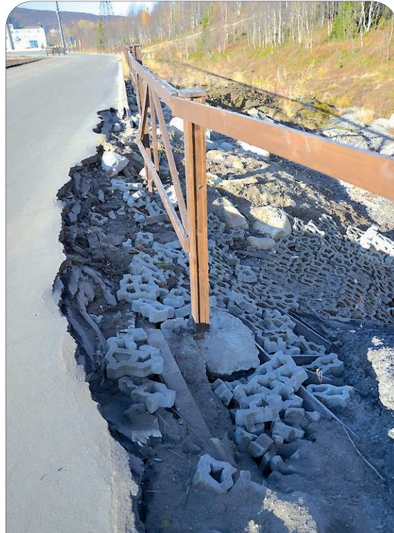
Во время последнего этапа реконструкции подрядчик повредил асфальт, уложенный до него.
