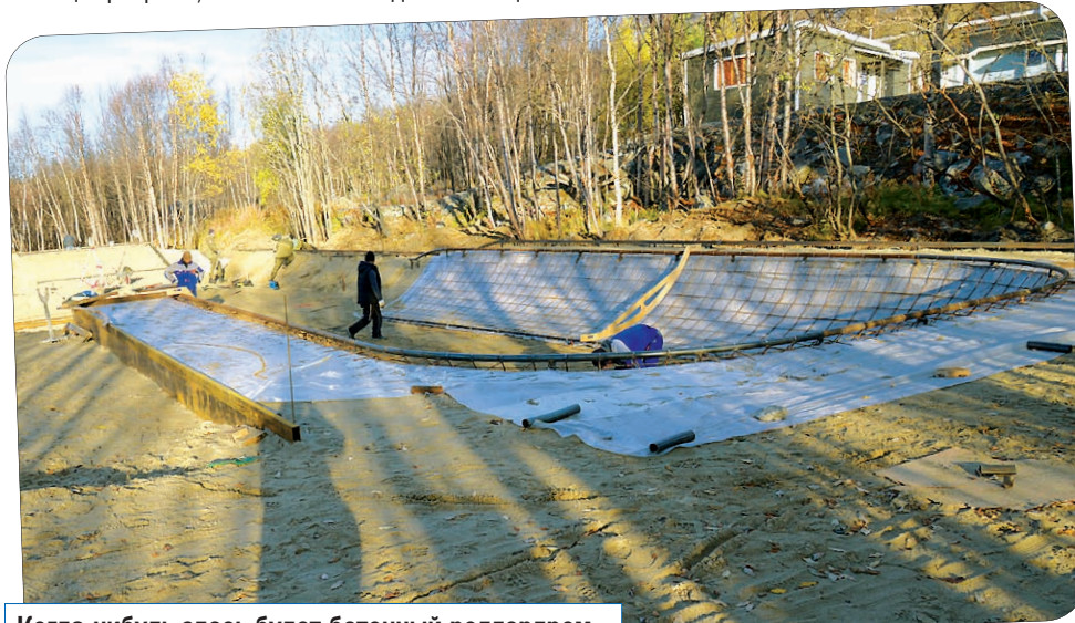
Когда-нибудь здесь будет бетонный роллердром.
