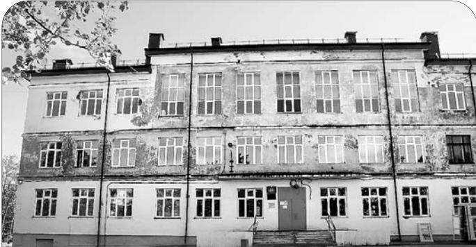
В школе № 26 идет ремонт фасада.
