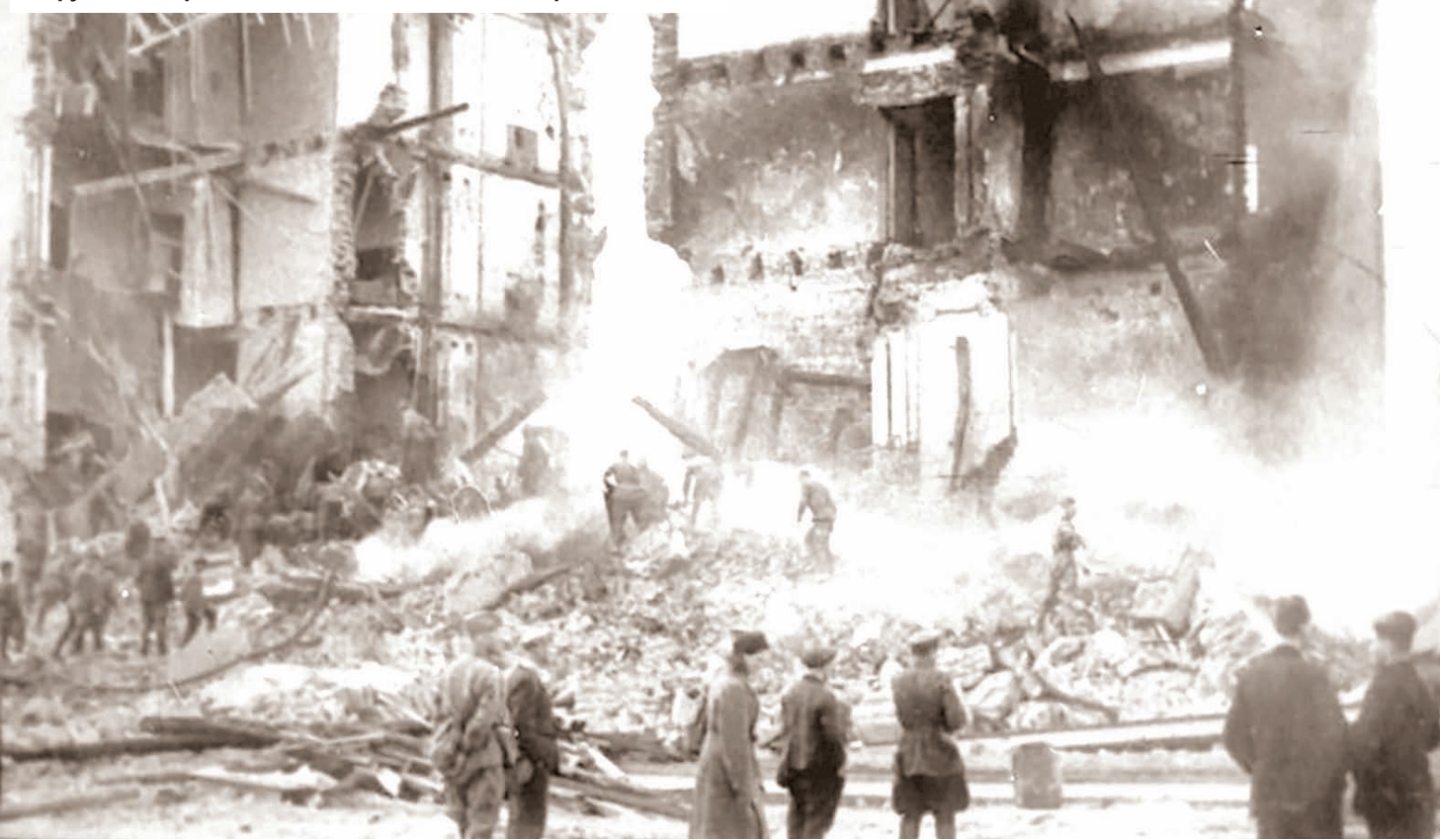
Разрушенный вражеской авиацией дом № 41 на просп. Сталина.
