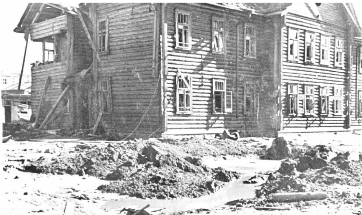
Водопровод, разрушенный немецкой авиабомбой на проспекте Сталина (в настоящее время проспект Ленина) у дома № 41 в Мурманске.
