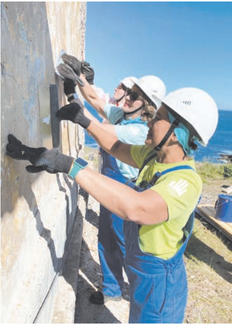
Евгения Чибис с тортом для волонтеров по случаю окончания ремонтных работ.
