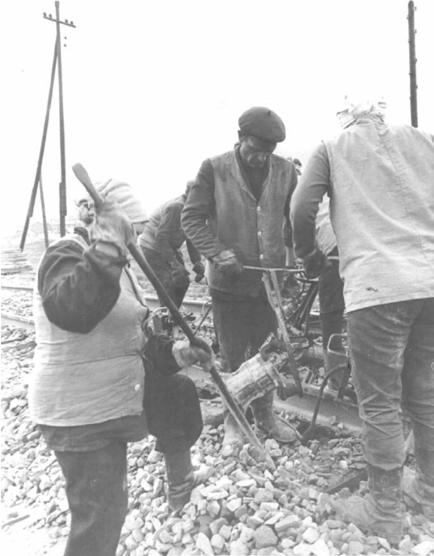
Ремонт пути Перегон Кола – Мурманск. 1979 год.
