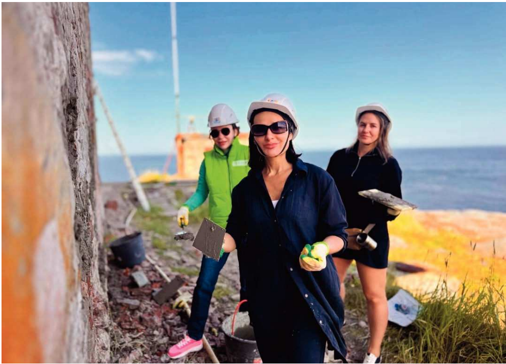
Евгения Чибис с тортом для волонтеров по случаю окончания ремонтных работ
