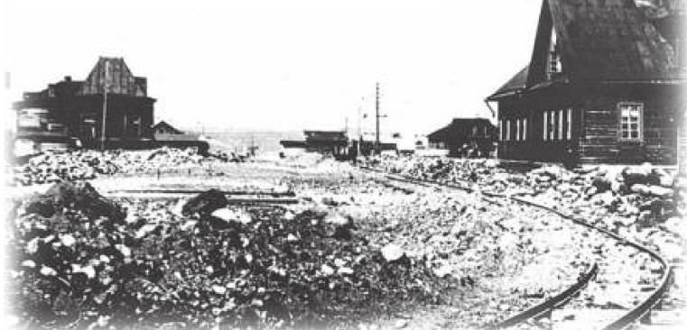
Рельсы декавильки на улице Воровского. Мурманск, 1929 год
